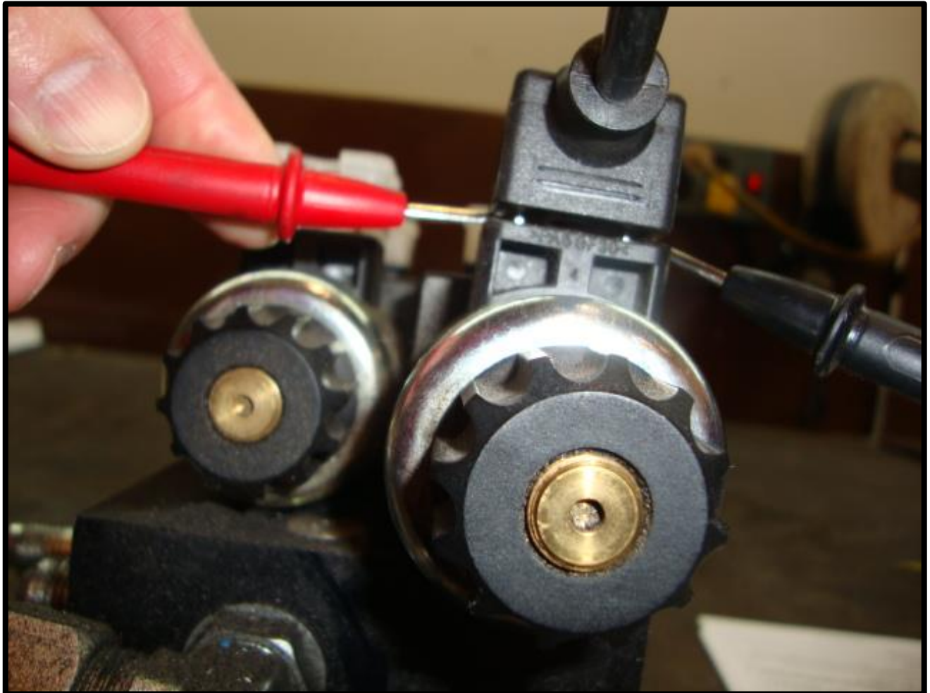
Fig. 8-4 Checking Din Plug Voltage
